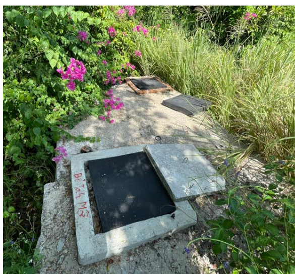
Bể tách dầu mỡ trạm A
