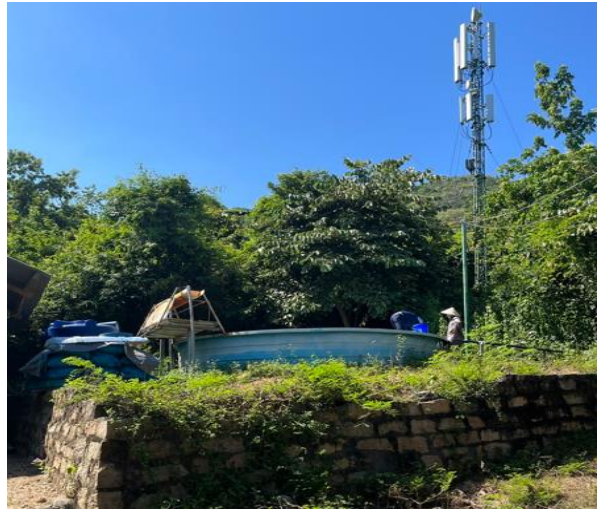
Bể chứa nước cấp sinh hoạt
